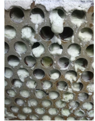
LIMPIEZA DE TUBOS CON RECIRCULACION DE QUIMICO DESINCRUSTANTE
