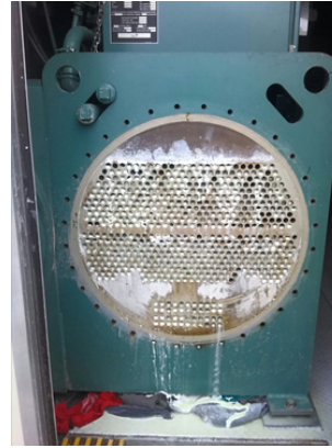
LIMPIEZA DE TUBOS CON RECIRCULACION DE QUIMICO DESINCRUSTANTE
